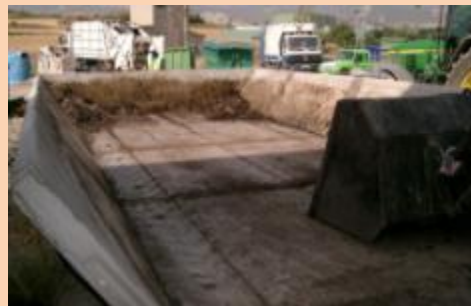
(d) sistema de compostaje estático y ventilado antes de ser llenado
